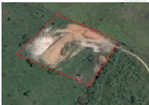
Figura 03 Area Lixão Imagem via Google Earth
