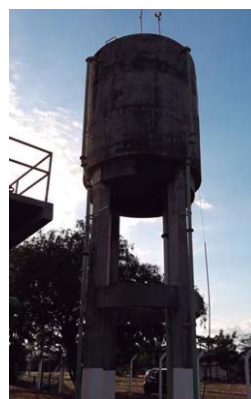
Foto 13 – Reservatório elevado de distribuição-ETA
