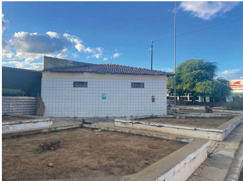
Figura 6 - Irá demolir o banheiro e demais canterios, para execução correta do projeto.
