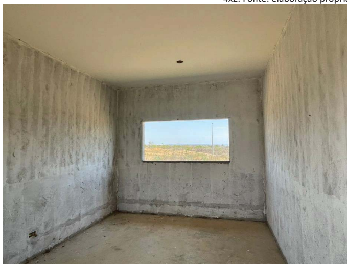
Figura 15 - Presença de pintura seladora e Caixinha para recebimento de tomada e lâmpadas, já com eletrodutos passados. Fonte: elaboração própria.
