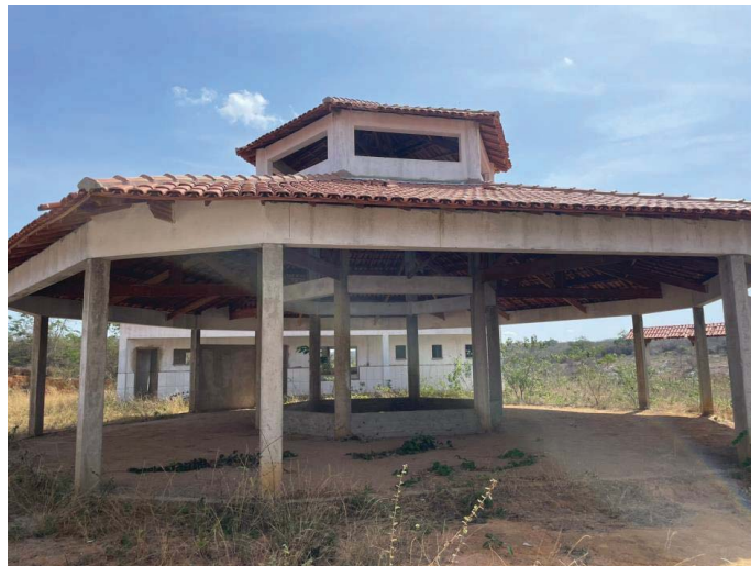
Figura 12 - Patio central conforme está "in loco". Fonte: elaboração própria.
