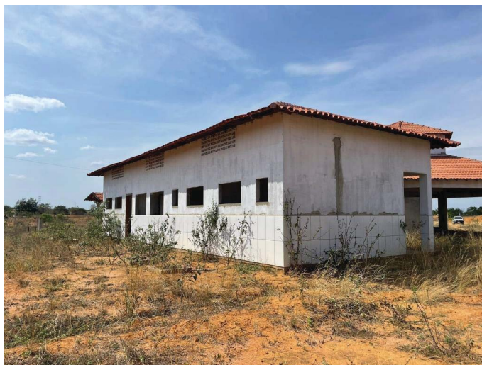
Figura 13 - Vista do fundo do bloco de serviço. Fonte: elaboração própria.
