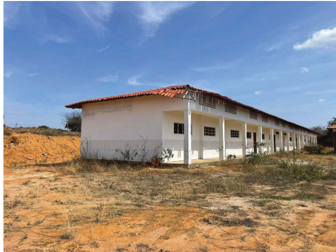
Figura 7 - Vista frontal do bloco pedagógico. Fonte: elaboração própria.
