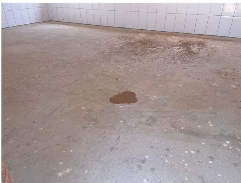
Figura 23 - Presença de formigueiro em alguns pontos. Fonte: elaboração própria.
