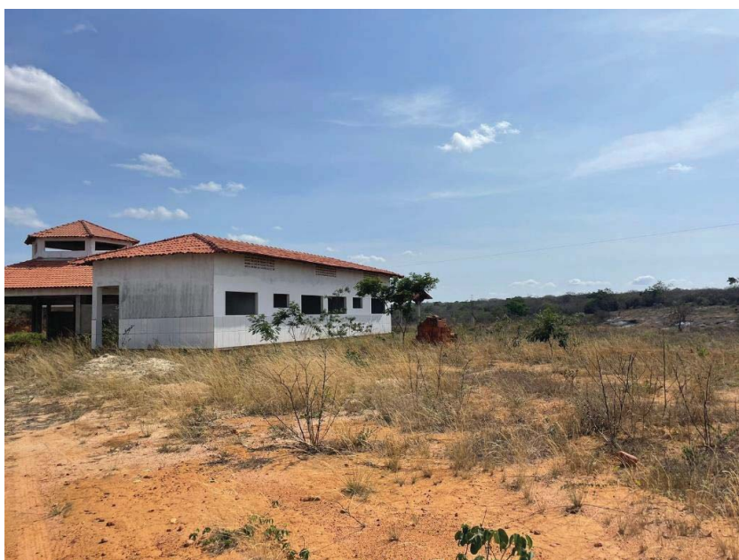
Figura 6 - Vista do Fundo do Bloco Administrativo. Fonte: elaboração própria.
