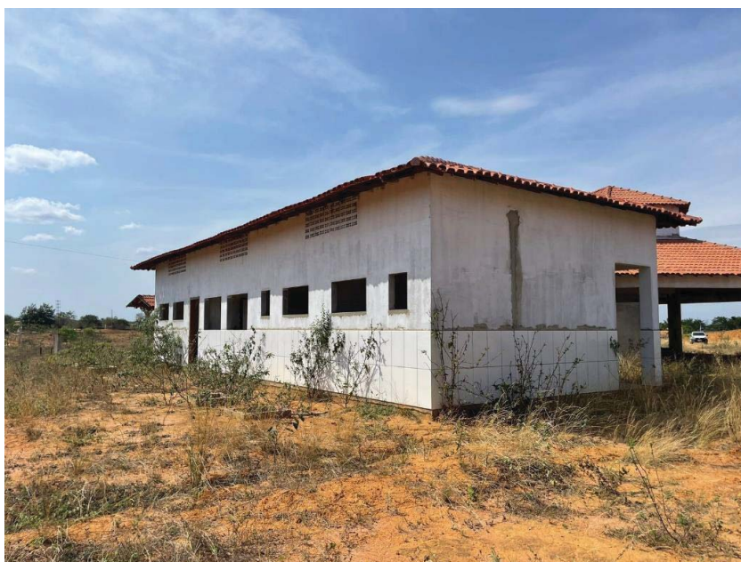
Figura 13 - Vista do fundo do bloco de serviço. Fonte: elaboração própria.
