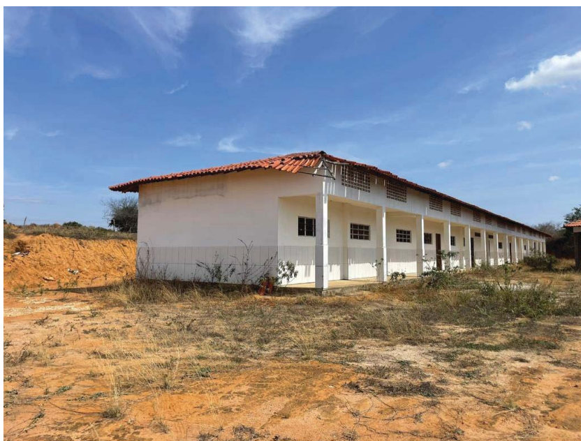
Figura 7 - Vista frontal do bloco pedagógico. Fonte: elaboração própria.
