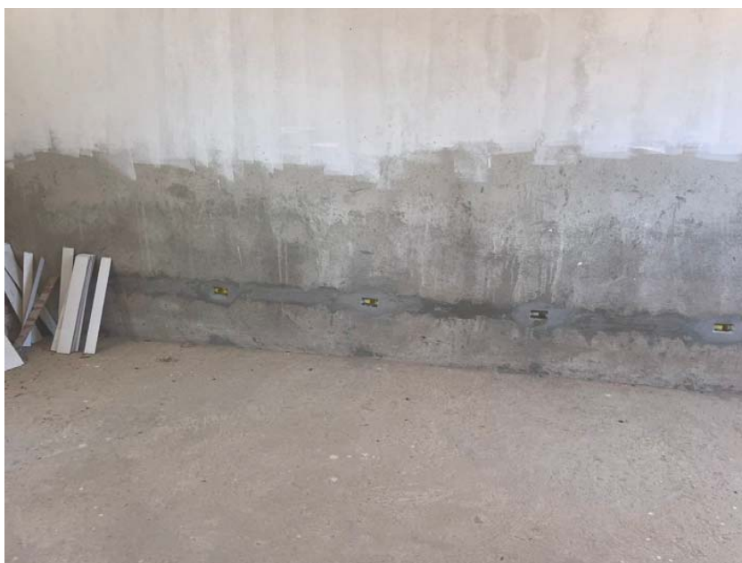
Figura 25 - Ausência de revestimento e bancada na sala de computação. Fonte: elaboração própria.
