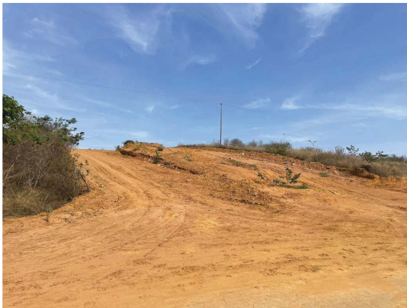
Figura 3 - Vista da entrada de acesso para construção da Escola de 06 salas. Fonte: elaboração própria.
