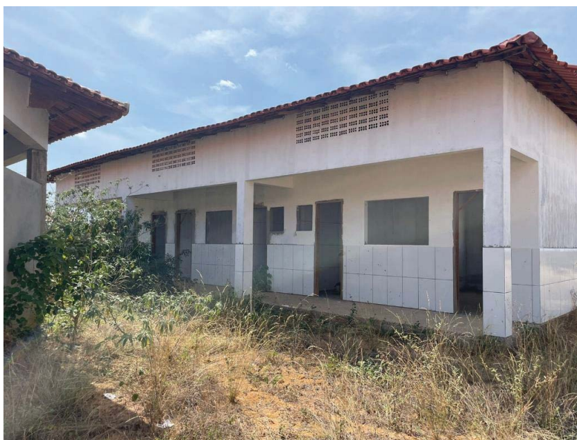
Figura 11 - Vista frontal do bloco de serviços. Fonte: elaboração própria.
