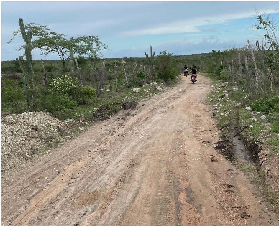
Figura 02 – Pavimentação existente das estradas vicinais citadas.
