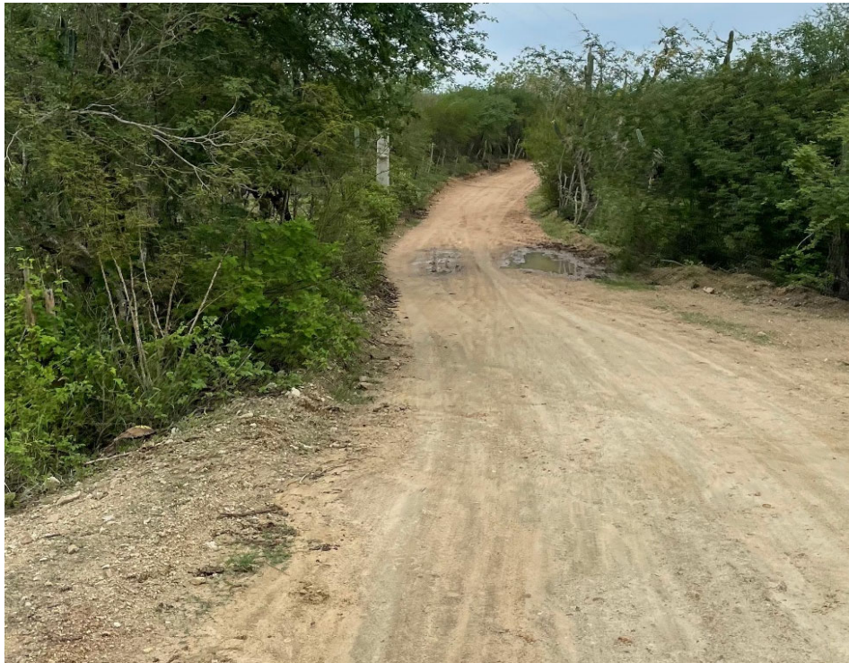
Figura 01 – Pavimentação existente das estradas vicinais citadas.
