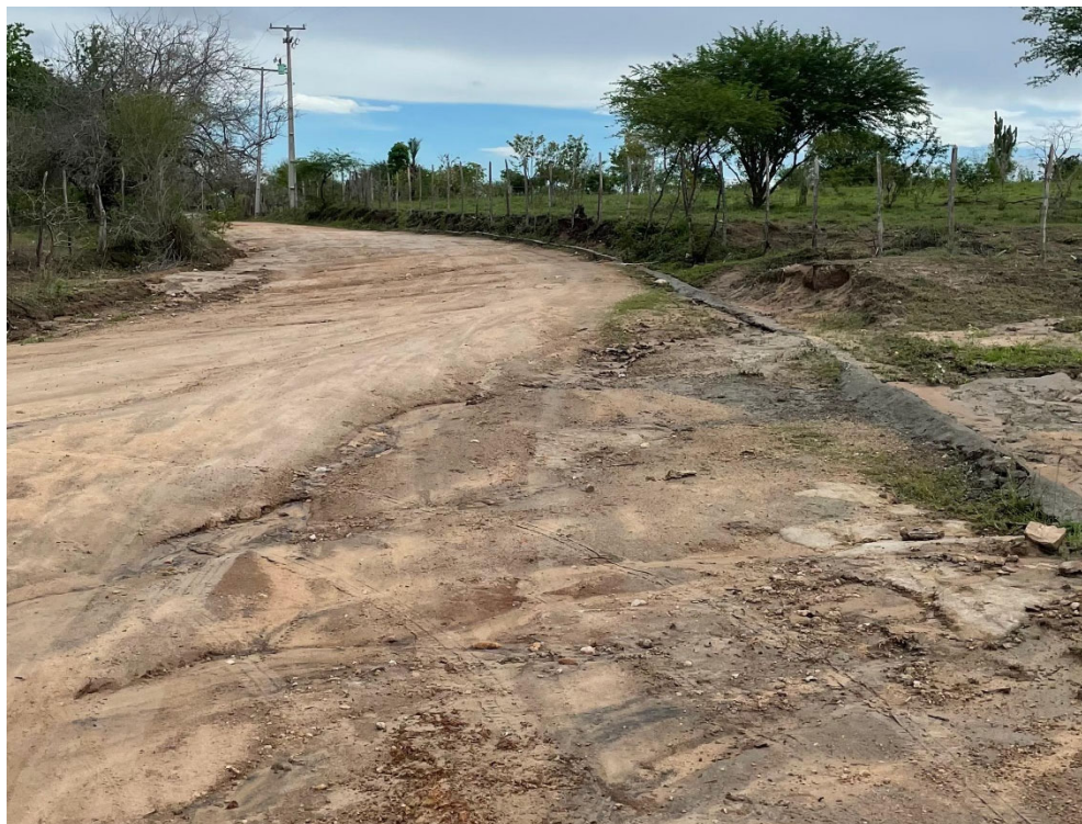
Figura 05 – Pavimentação existente das estradas vicinais citadas.
