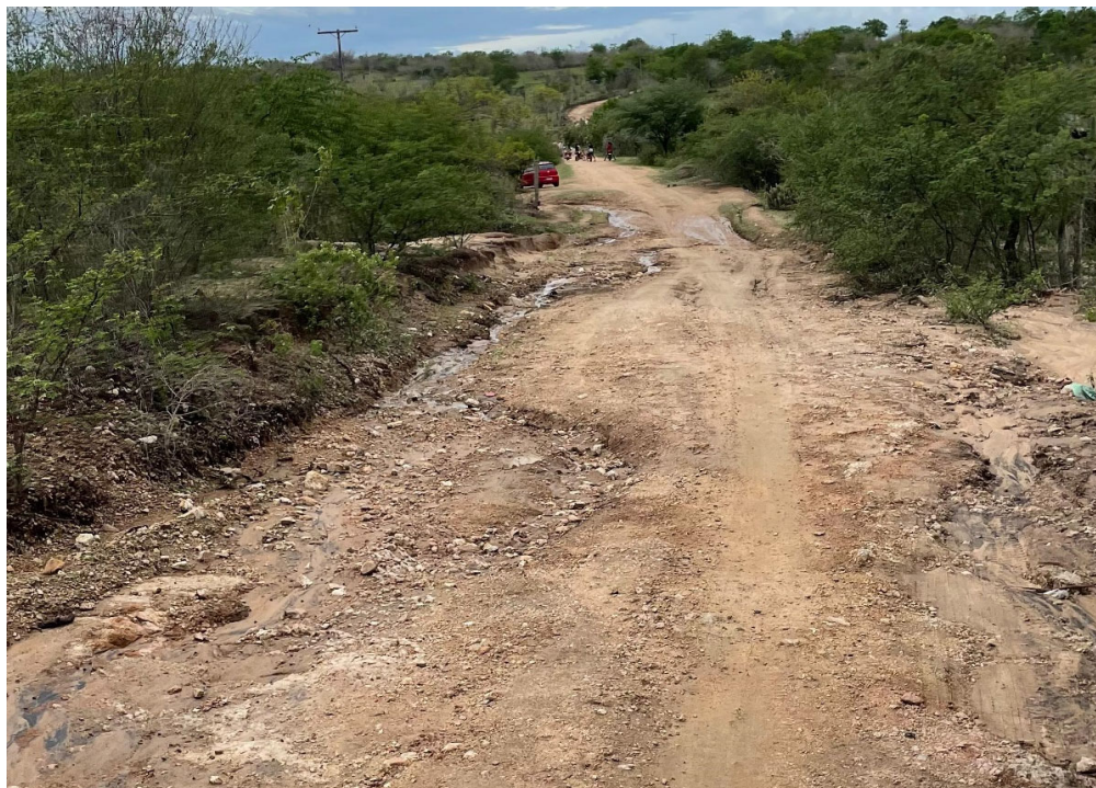
Figura 06 – Pavimentação existente das estradas vicinais citadas.
