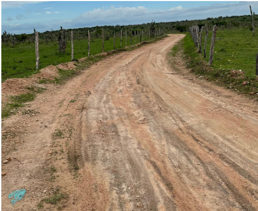
Figura 04 – Pavimentação existente das estradas vicinais citadas.
