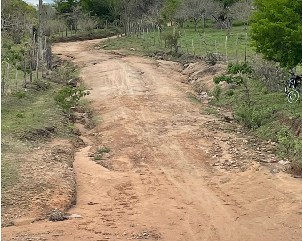
Figura 07 - Pavimentação existente das estradas vicinais citadas.
