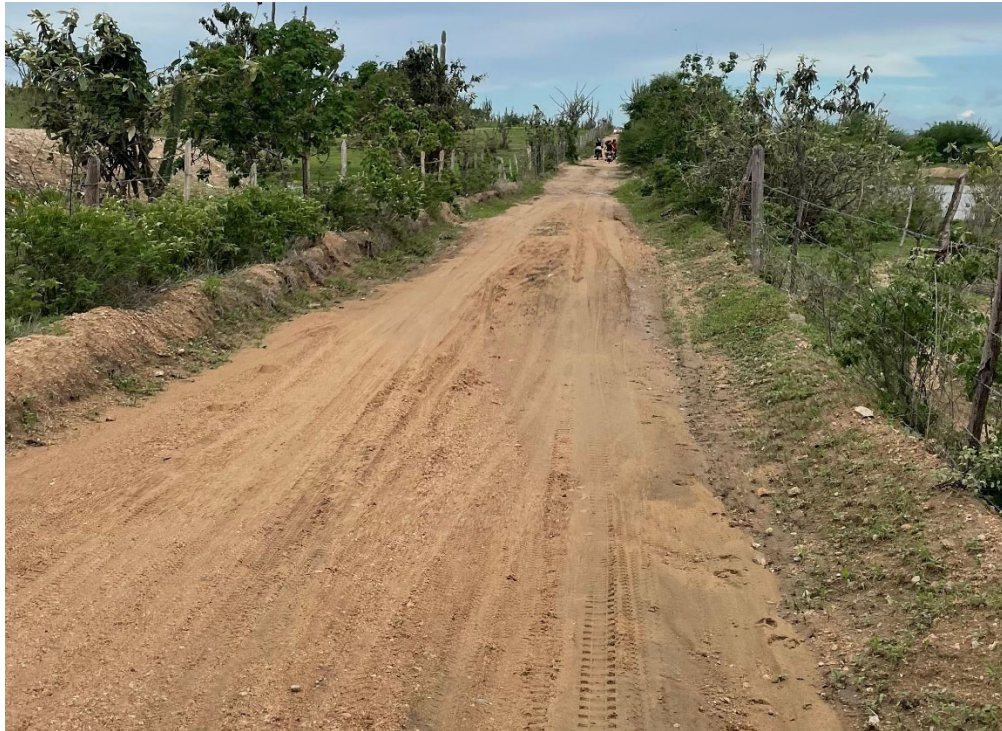
Figura 03 – Pavimentação existente das estradas vicinais citadas.
