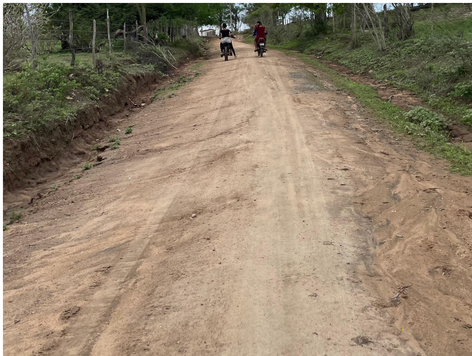
Figura 08 - Pavimentação existente das estradas vicinais citadas.
